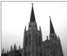
<Fotografia normale in condizioni di controluce>
